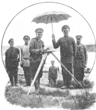
Работы по съемкѣ.
