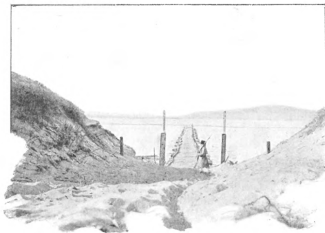
Мостъ черезъ р. Тюмень-ула.
