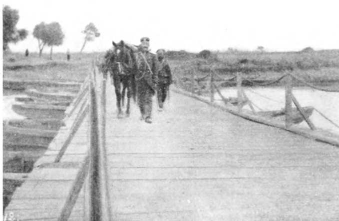
Переправа развѣзда черезъ мостъ.
