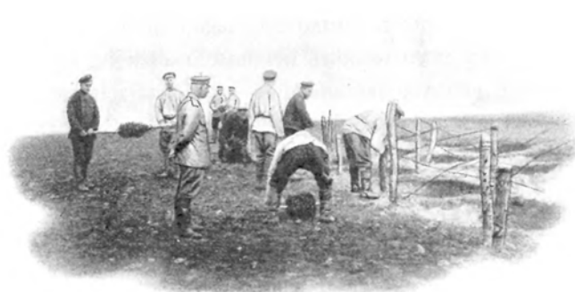
Постройка проволочныхъ загражденій.
