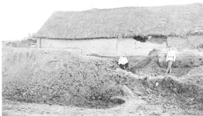
Брустверь, разрушенный снарядами.
