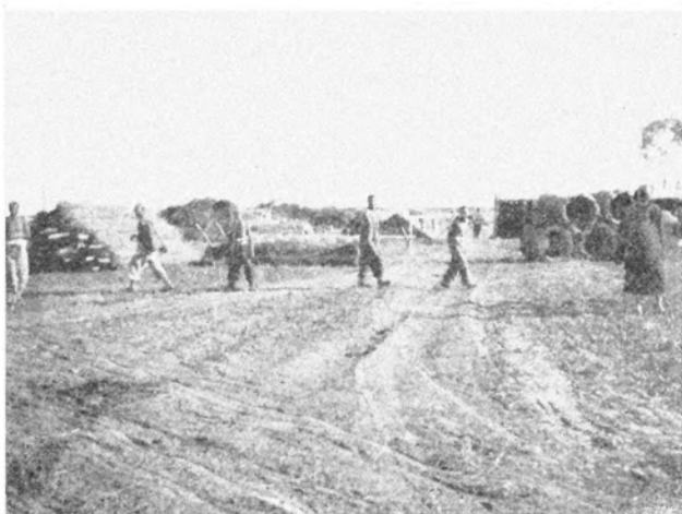
Рабочіе китайцы въ инженерномъ складѣ.
