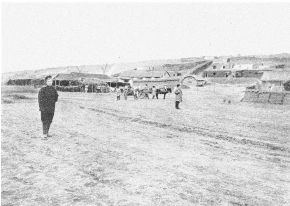
Землянки офицеровъ 19-го сапернаго батальона.
