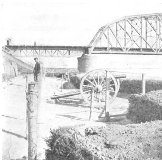
Охрана моста на р. Нонхе у ст. Фулярди.
