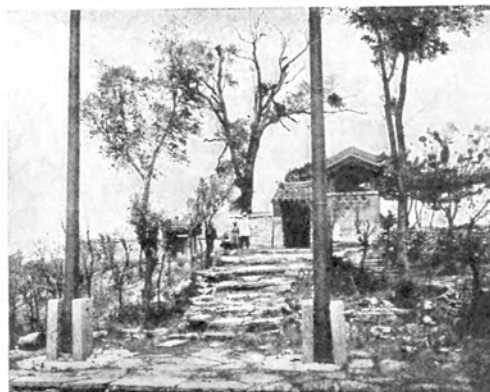
Кумирня Флекшонъ близъ Ляояна.
