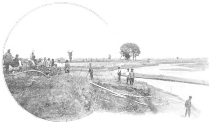
Начало постройки моста.
