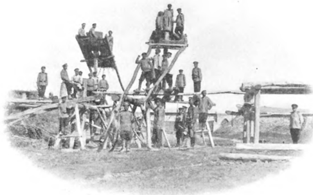
Постройка моста черезъ оврагъ.
